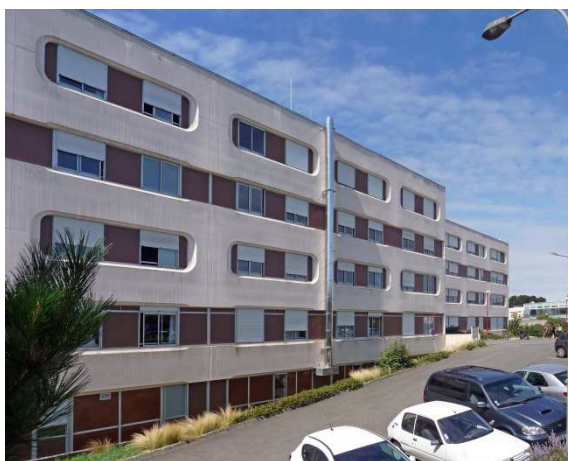
Bâtiment C « G. CLEMENCEAU »
